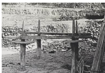
圖 20 穀倉基座及防鼠圓盤構造
