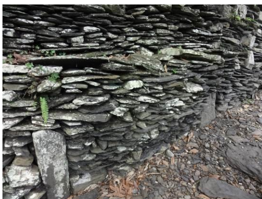
擋水牆工程之施作與修繕，其主要的結構壁體購過一個一個的中柱石板(照片中的立板)來支撐並區隔每一個區段間的石板擋土牆設施工程，具有結構上的意義，也有隔間的意義。
