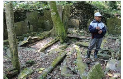
上圖就是 MVI_5900 耆老提到的石板屋屋內有老樹樹根導致地面石板向下塌陷的問題
