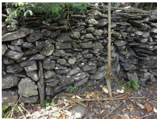
右上圖是主要大街的擋土壁工程，因為大街的右側與左側隨著山坡地高低差(約有一層樓高)的問題，擋土極為重要，所以立柱的尺寸較大，本張照片為街道旁的族人屋外之擋土圍牆，因內部地基的土壤不超過1米，擋土牆厚度較薄(約有36cm左右)，中間的結構立柱尺寸較薄。
