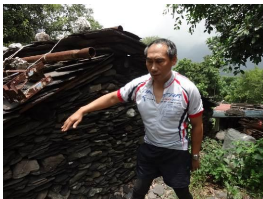
老七佳部落郭東雄老師母親娘家的石板屋建築側牆
