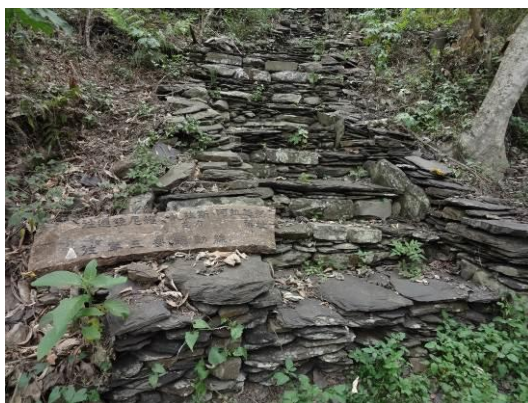
上圖為舊來義部落的主要大街之石板階梯，此部份的修建工程約在民國100至101年間，經費來源分別是水保局與原住民會，根據部落裡的耆老辛初男先生說明，修建工程均以傳統的工法施作，石板則是從早期劉清勇先生家開設的石板裁切工廠撿拾石板廢料，與現地其他房舍拆除後的剩餘石片修築(原本大街及有遺留的石板階梯殘跡)，並以任先民教授在1957年間在來義舊社拍攝的大街照片為依據，進行相關的修繕工事。
